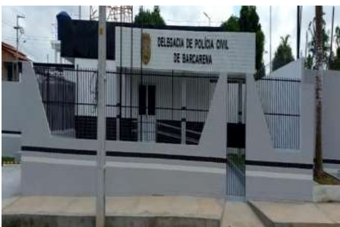
IMAGEM 3: Nova Delegacia de Barcarena, após construção. FONTE: FISP, 2023.
