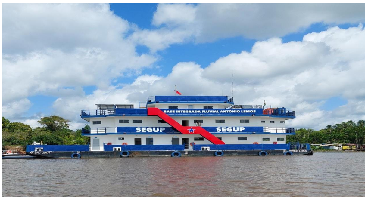
Figura 21: Base Integrada Flutuante “Antônio Lemos” localizada rio Tajapurú, no Município de Breves, no ano de 2023.
